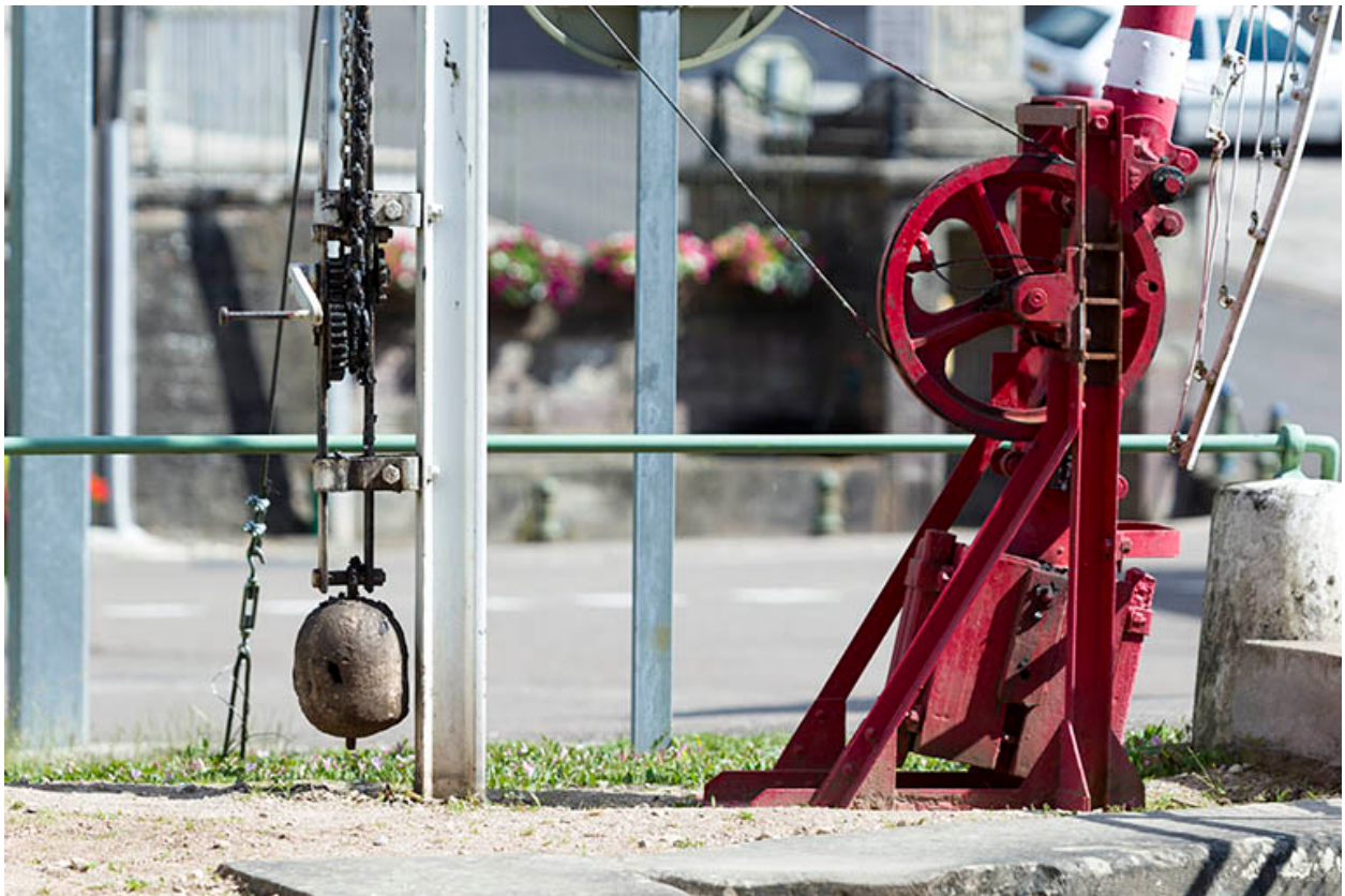
Détail du mécanisme de la barrière.
