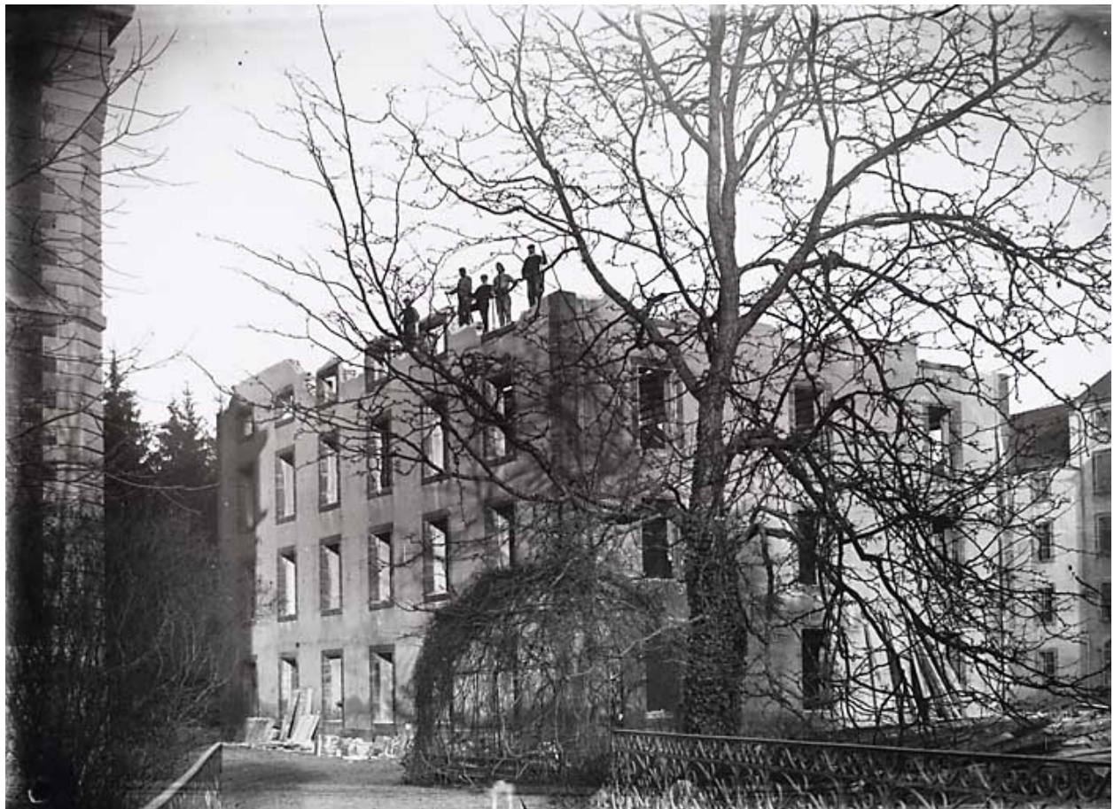
Démolition de l'ancienne filature.
