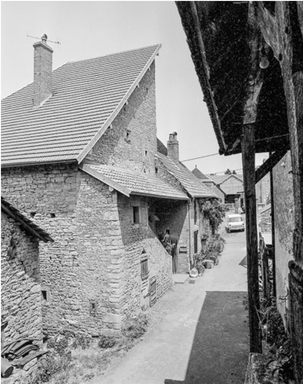
Ferme cadastrée 1973 AB 92, située entre la rue de la Traverse et la rue de l'Arcade : façade antérieure.
