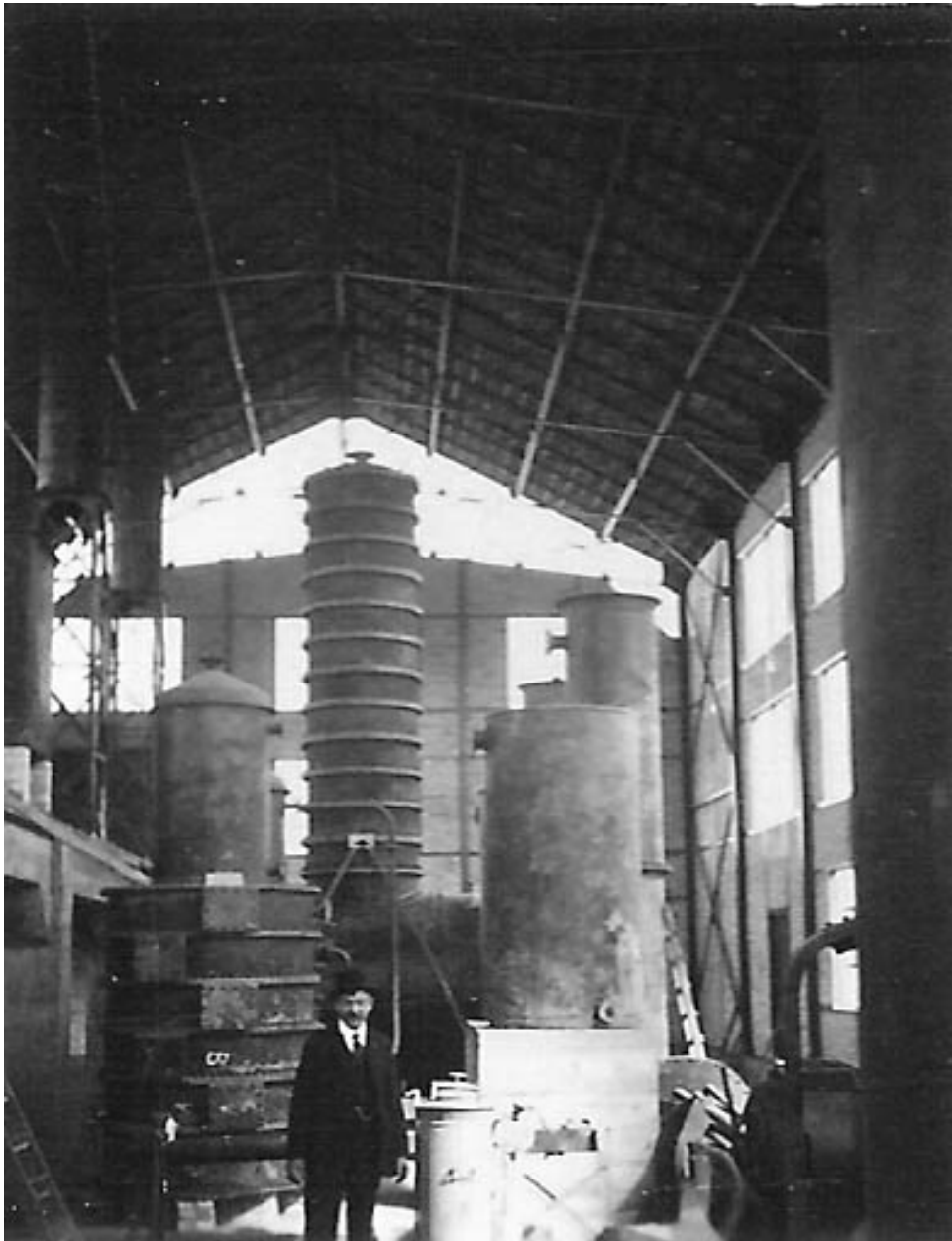
Vue intérieure de la raffinerie.
