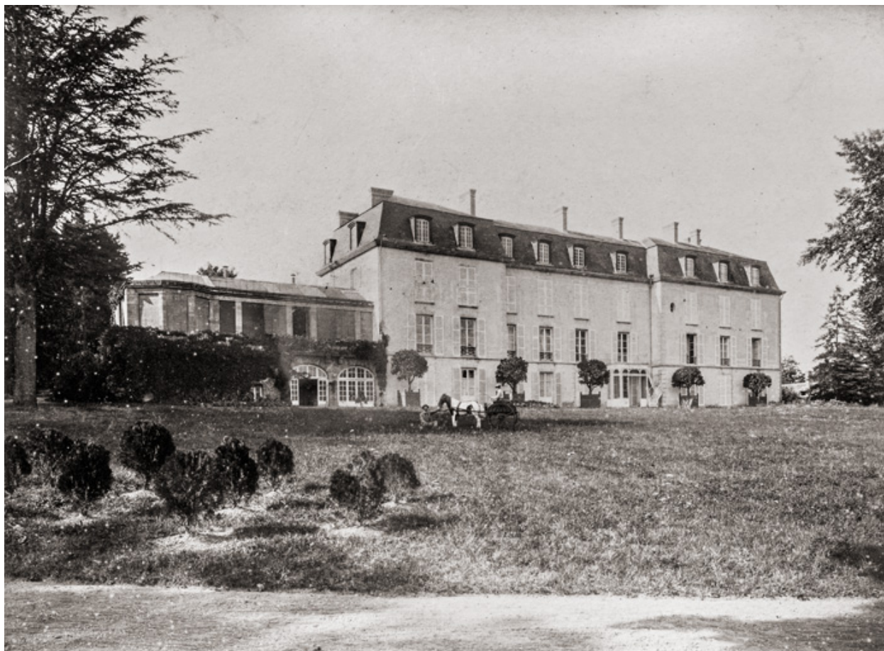
Façade sud-est du corps de logis.
