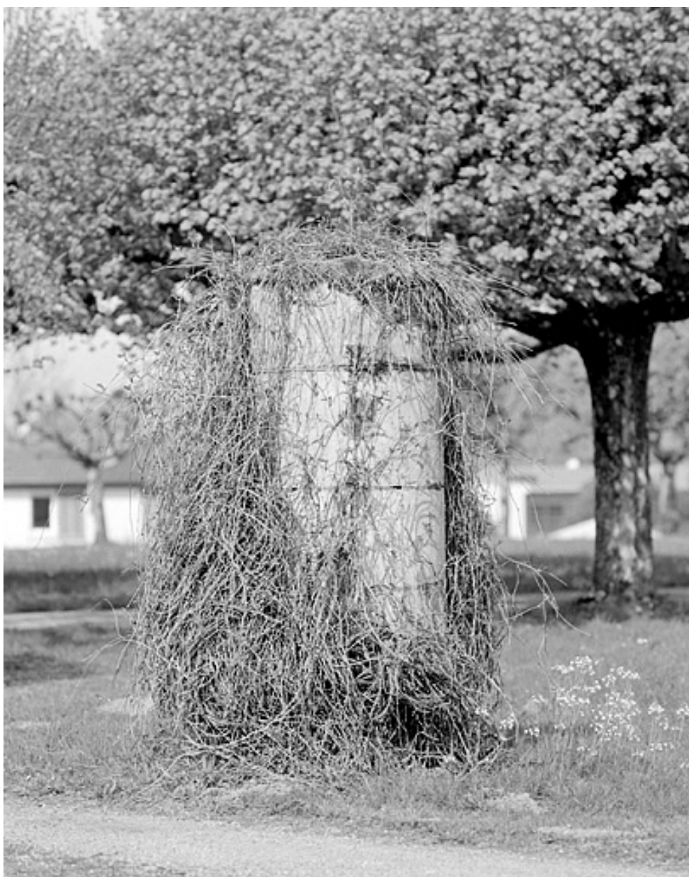
Pilier sud de la mire nord.
