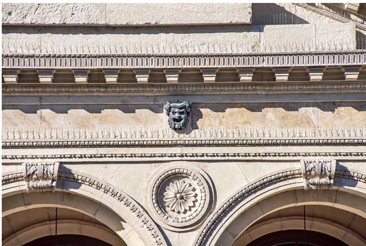
Façade antérieure, étage : décor.
