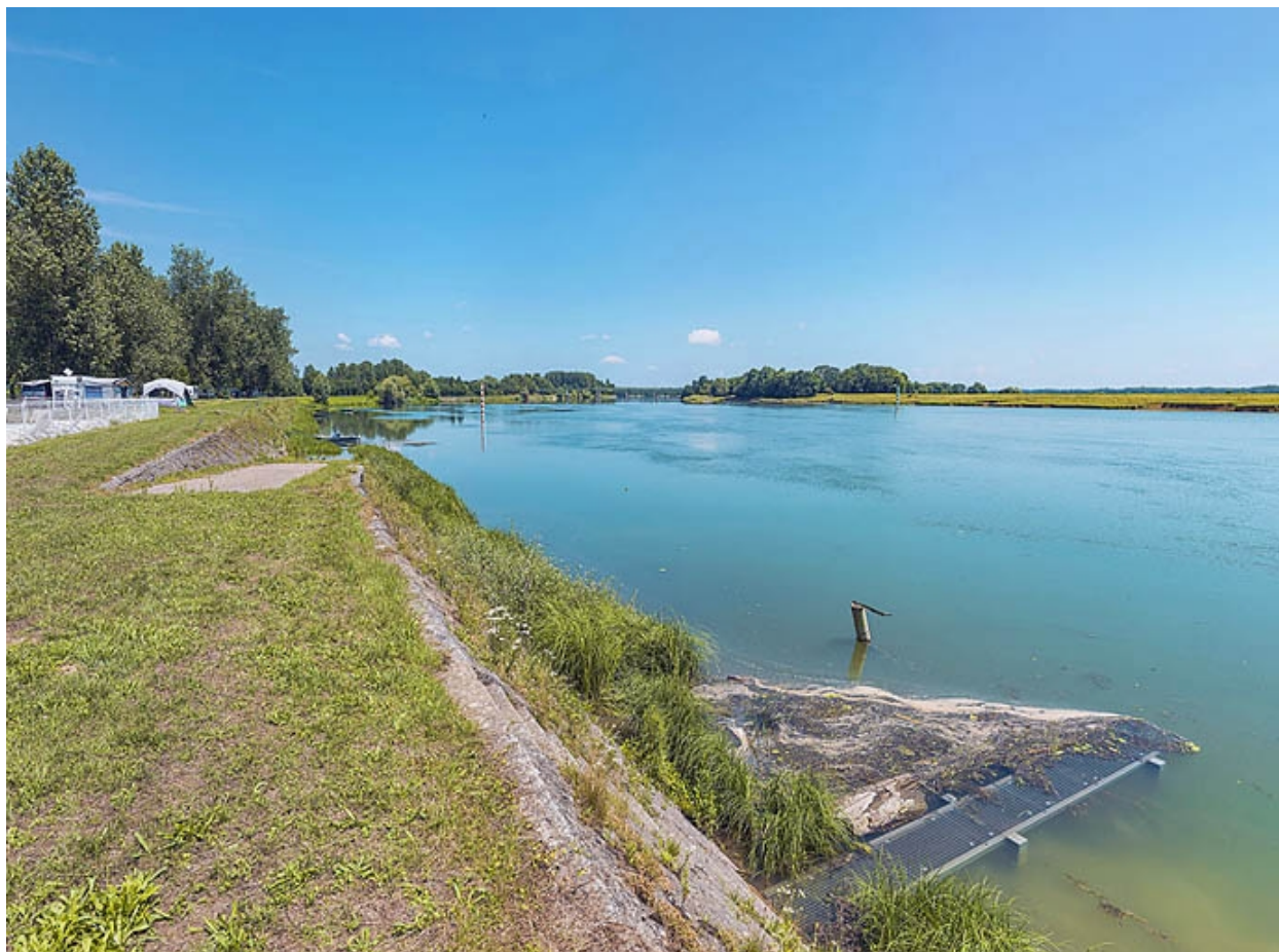
Rampe, perrés et escalier du port d'Uchizy.
