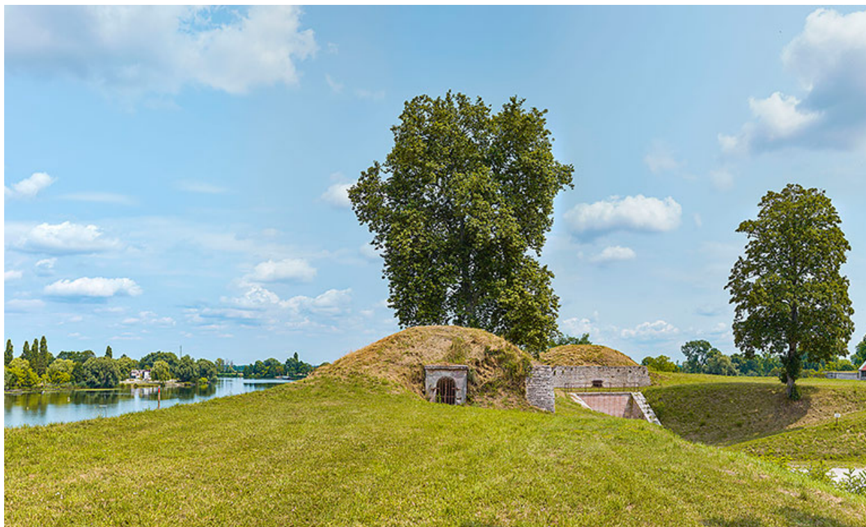
Casemates sur le terre-plein.
