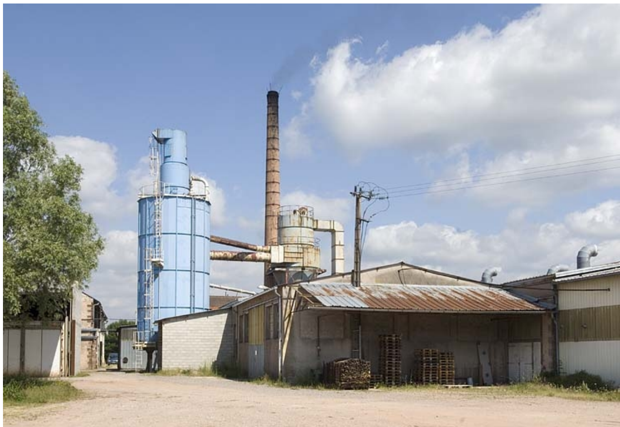
Silo et cheminée. Vue d'ensemble.
