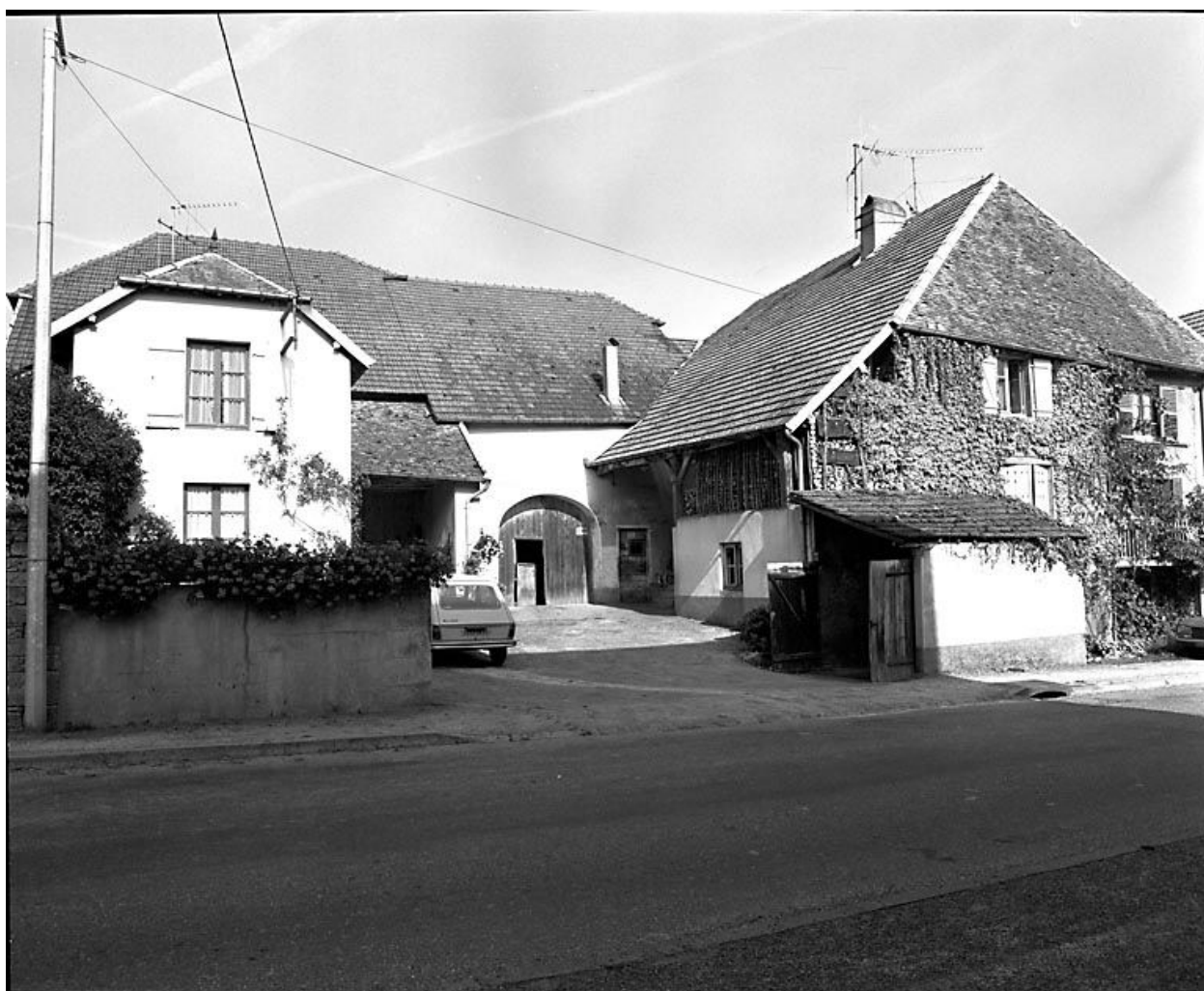
Façade antérieure sur cour ouverte.
