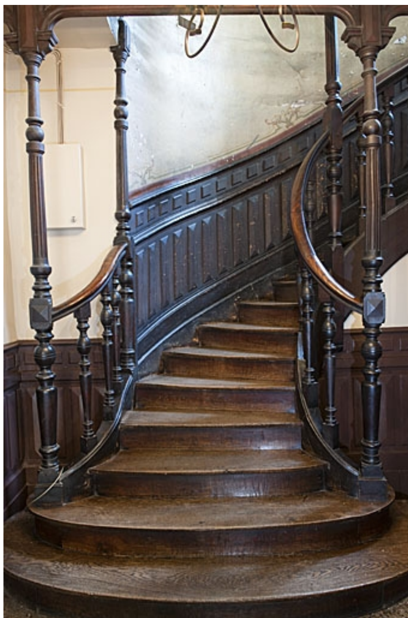
Détail du départ de l'escalier.
