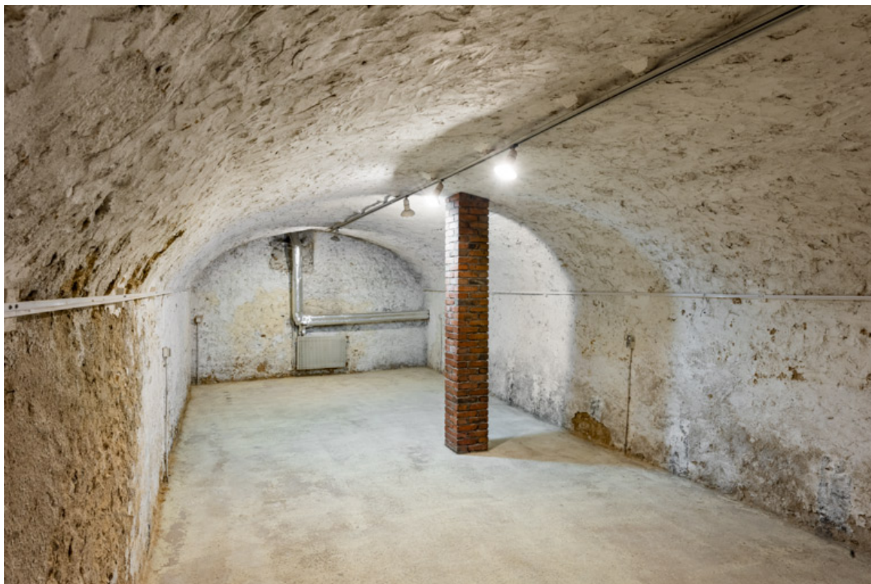
Cave voûtée en sous-sol.
