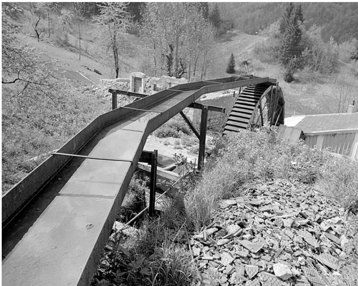
Canal d'amenée métallique et roue hydraulique.
