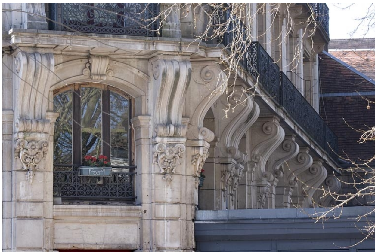
Détail des consoles soutenant le balcon filant.
