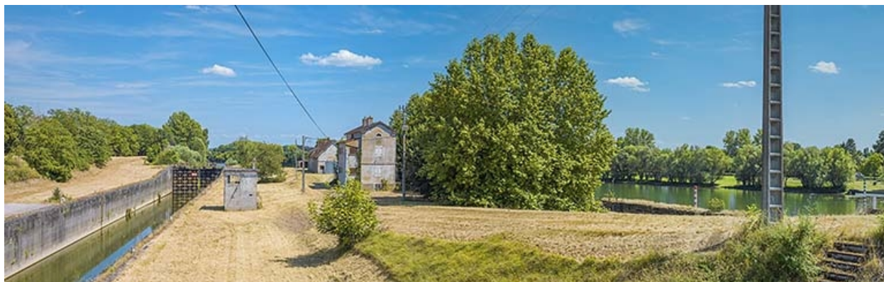
Vue d'ensemble du site d'écluse depuis l'aval.
