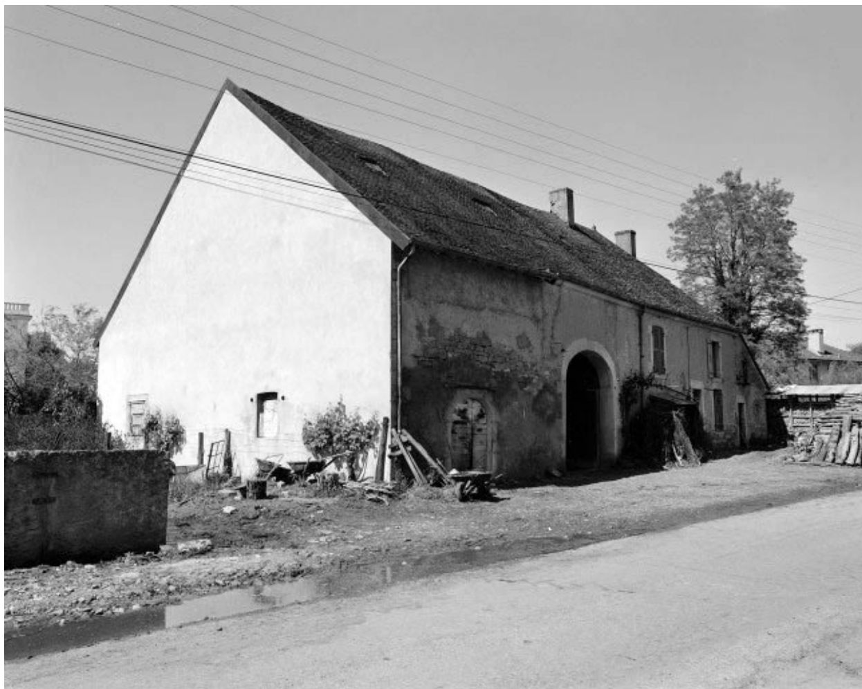
Ferme située rue Neuve : façade antérieure.
