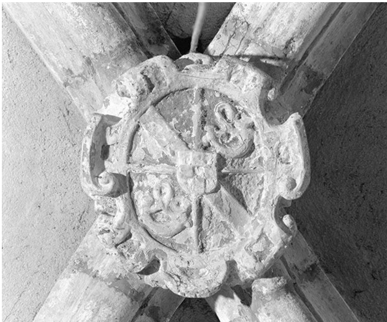
Clef de voûte du chœur.
