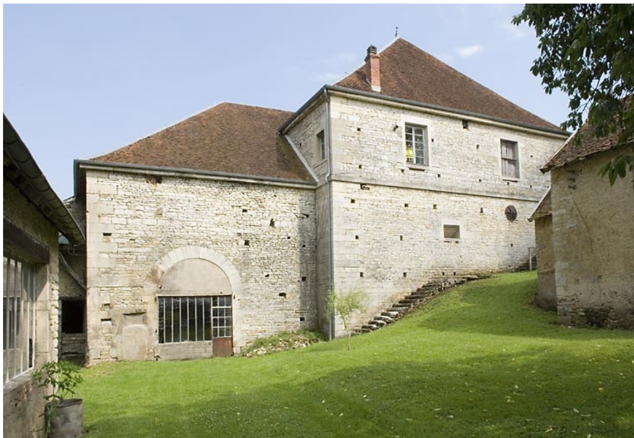
Le haut fourneau vu depuis l'ouest.
