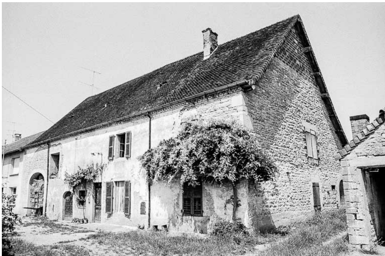
Ferme cadastrée 1960 AH 65 : façades antérieure et latérale droite.
