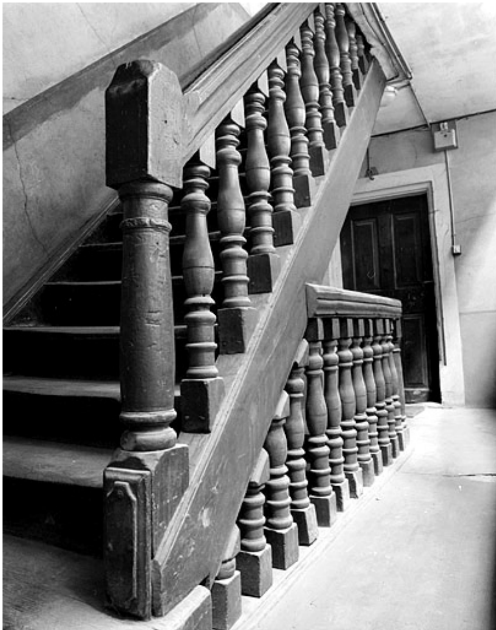
Escalier vu au niveau du premier étage.
