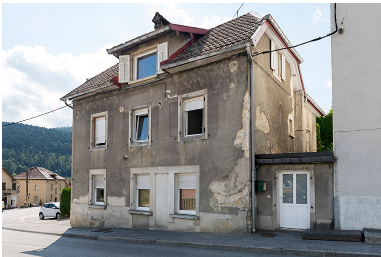
Façades antérieure et latérale droite.
