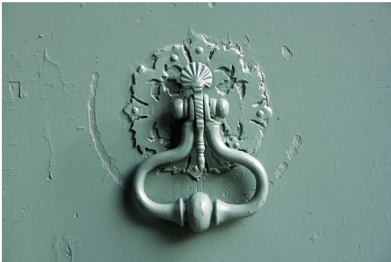
Détail du heurtoir du portail d'entrée.
