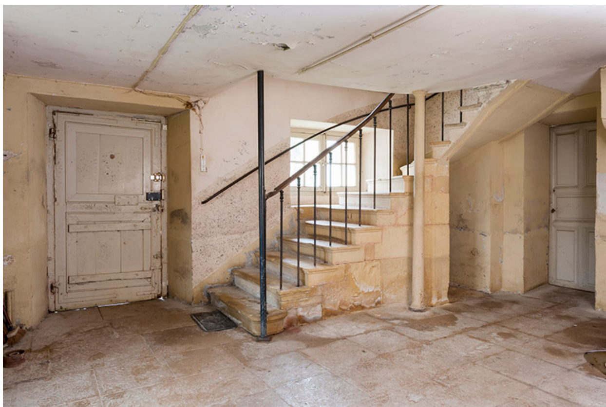
Escalier d'accès au rez-de-chaussée depuis le sous-sol.
