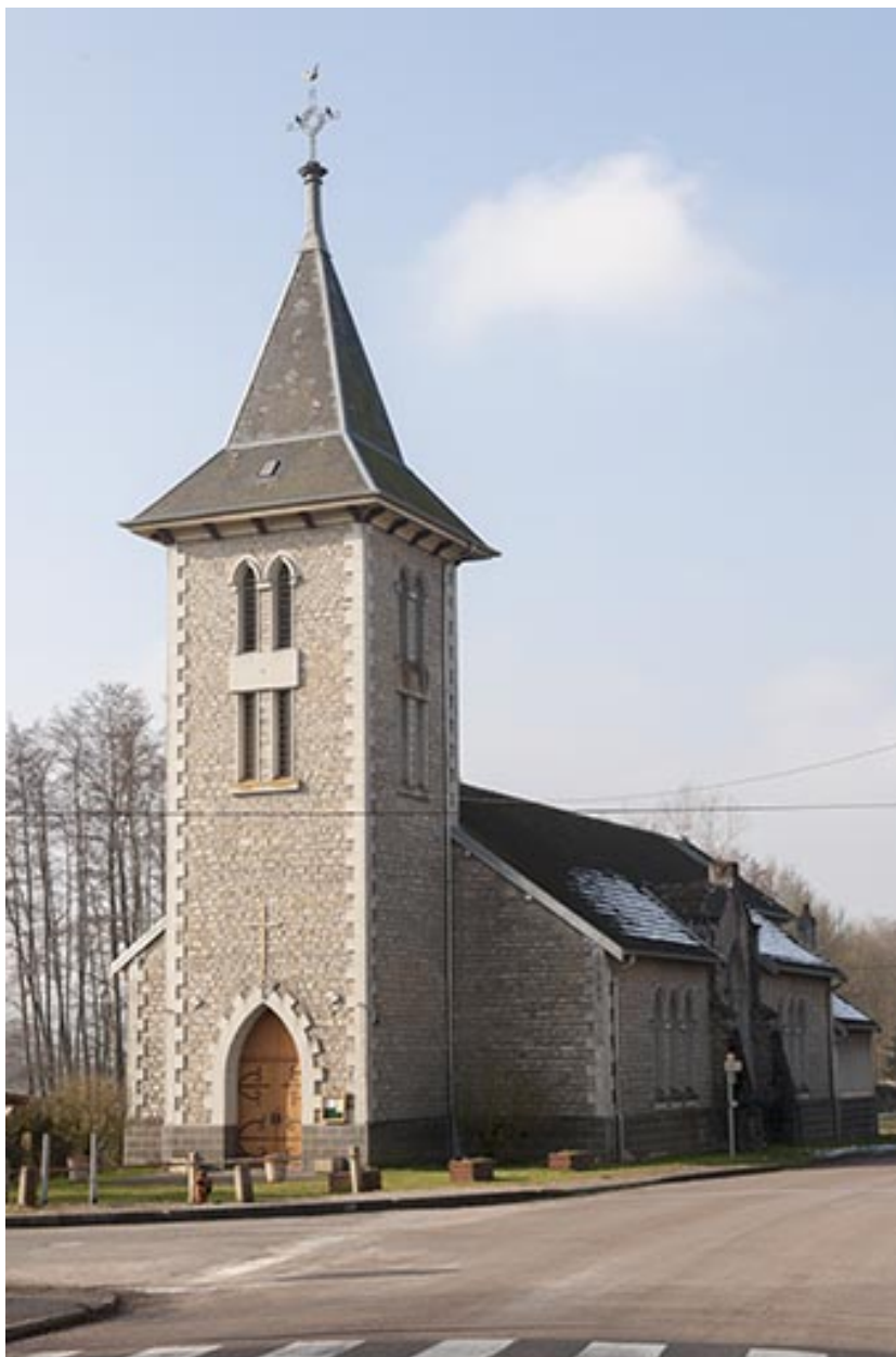
Façade antérieure, vue de trois quart droite.
