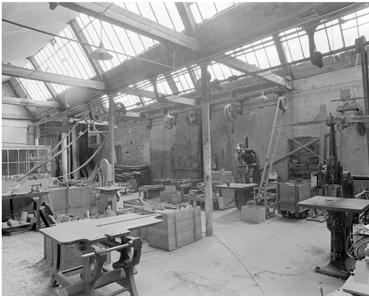
Vue d'ensemble de l'atelier depuis le sud-est.
