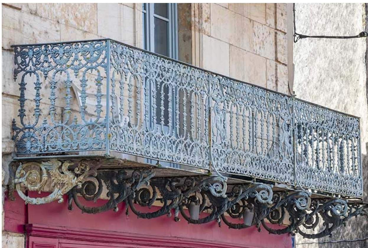
Le balcon du premier étage.
