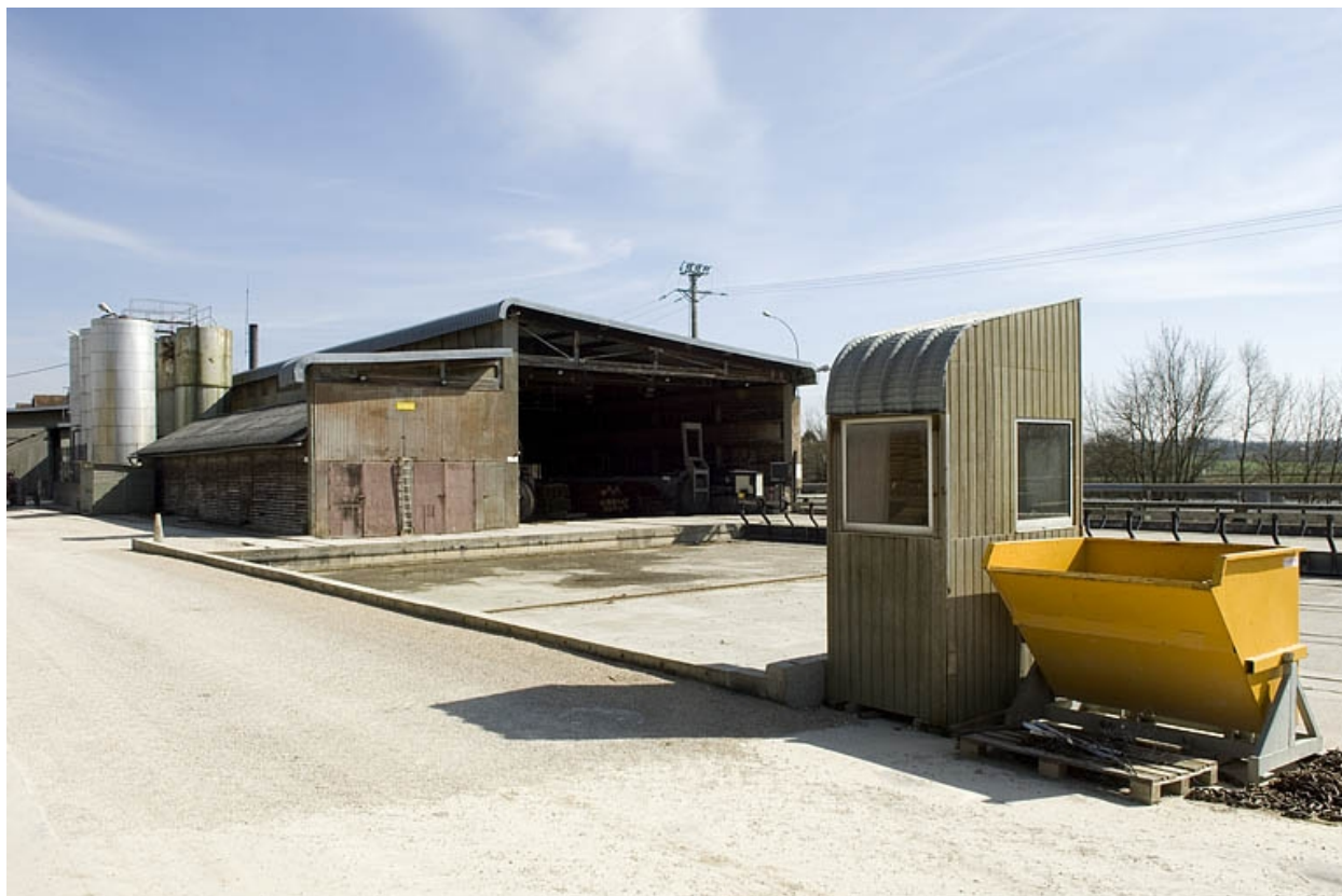
Atelier de fabrication depuis le nord-ouest.
