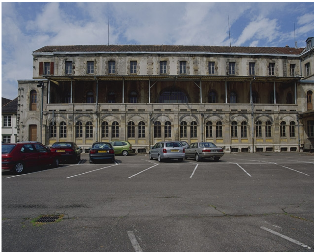
Façade postérieure de l'ancien couvent (actuellement bureaux).
