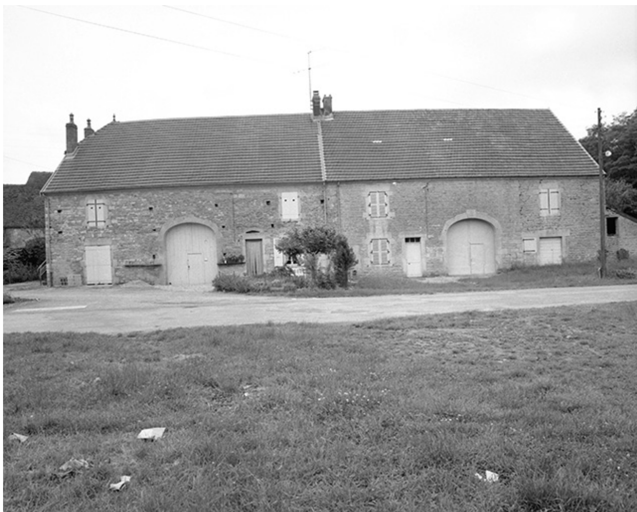
Fermes doubles : vue d'ensemble.
