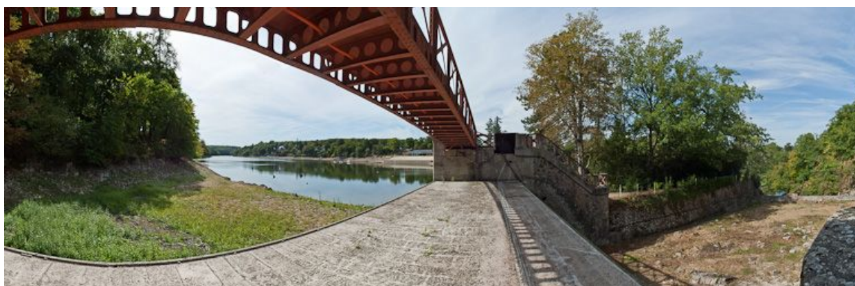
Vue du déversoir.
