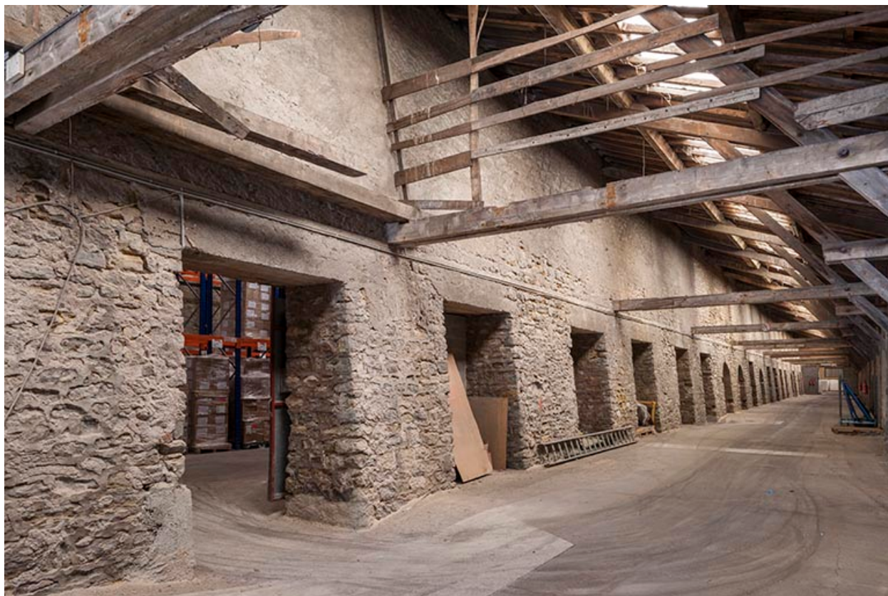
Atelier de fabrication (berne) : ancien quai.
