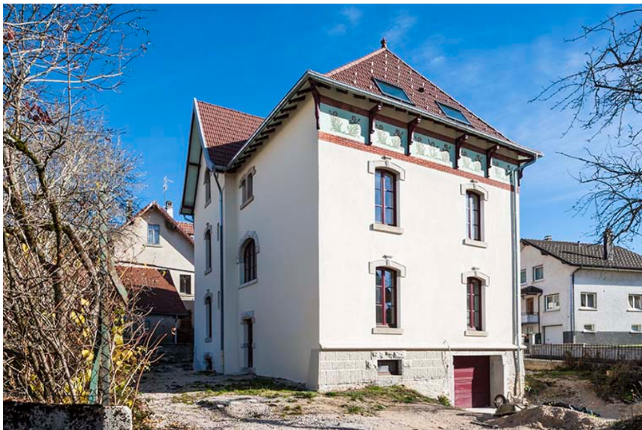
Maison : façades postérieure et latérale gauche.
