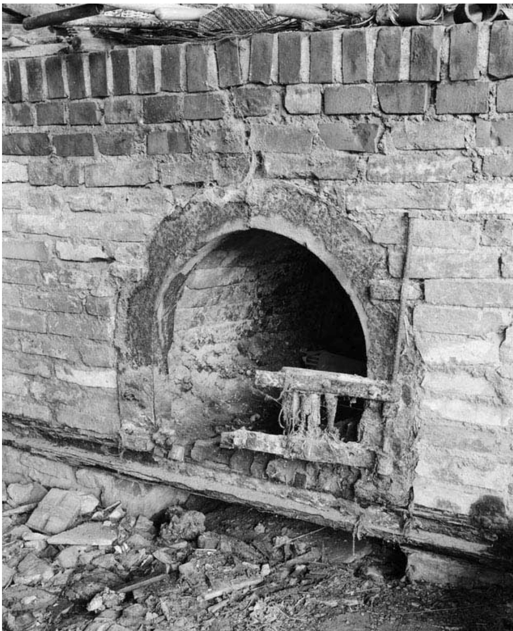
Détail du four : bouche d'enfournement du bois.
