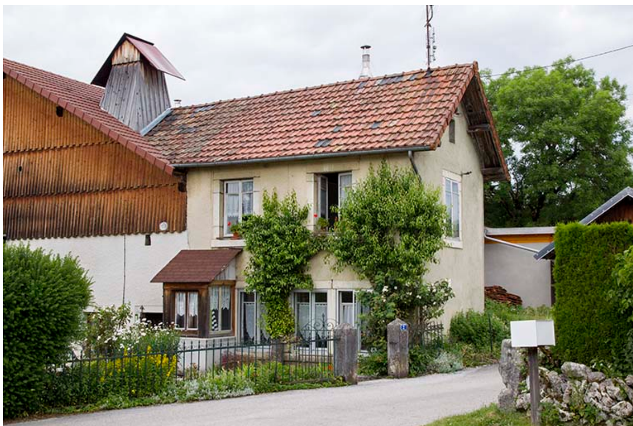
Façade antérieure de l'atelier.
