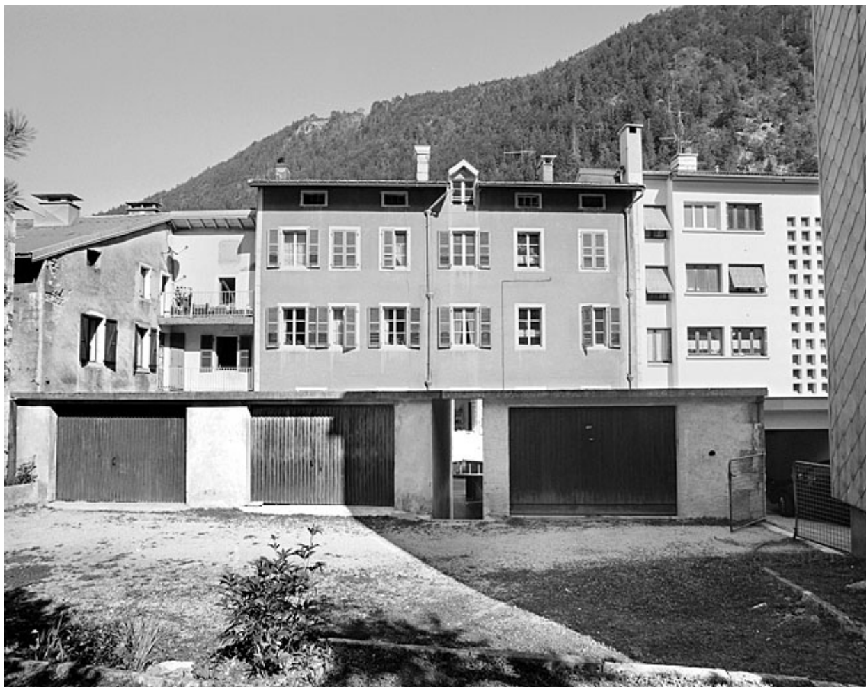
Elévation postérieure et garages.
