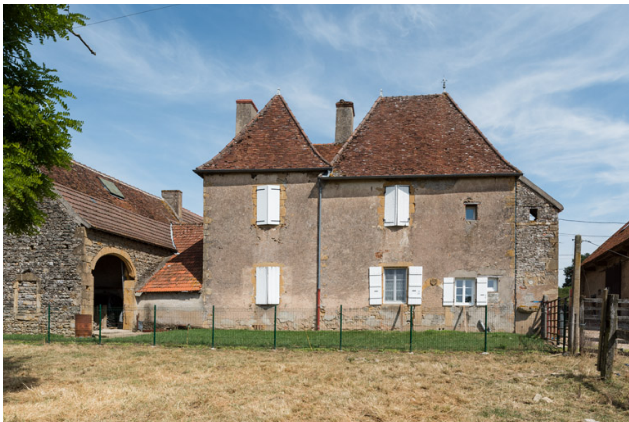
Façade postérieure de la maison
