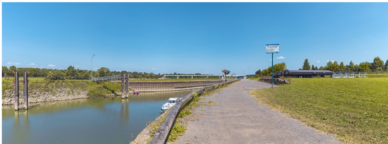
Le site d'écluse vu d'aval.
