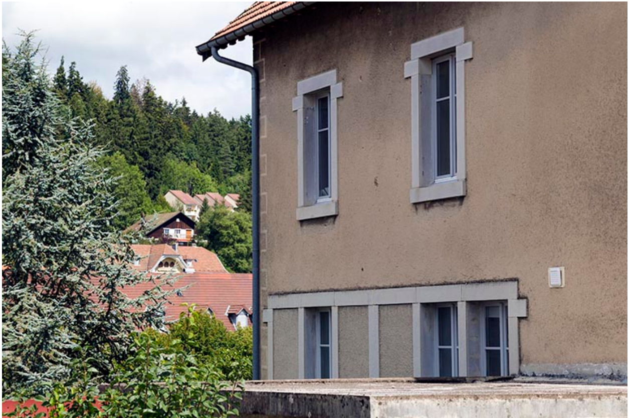
Façade latérale gauche : fenêtres multiples.
