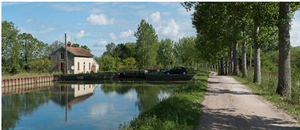
Vue du site d'écluse depuis l'amont.
