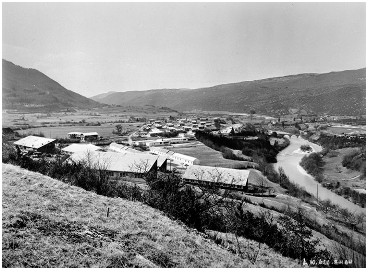
Cité de Vouglans [vue d'ensemble].
