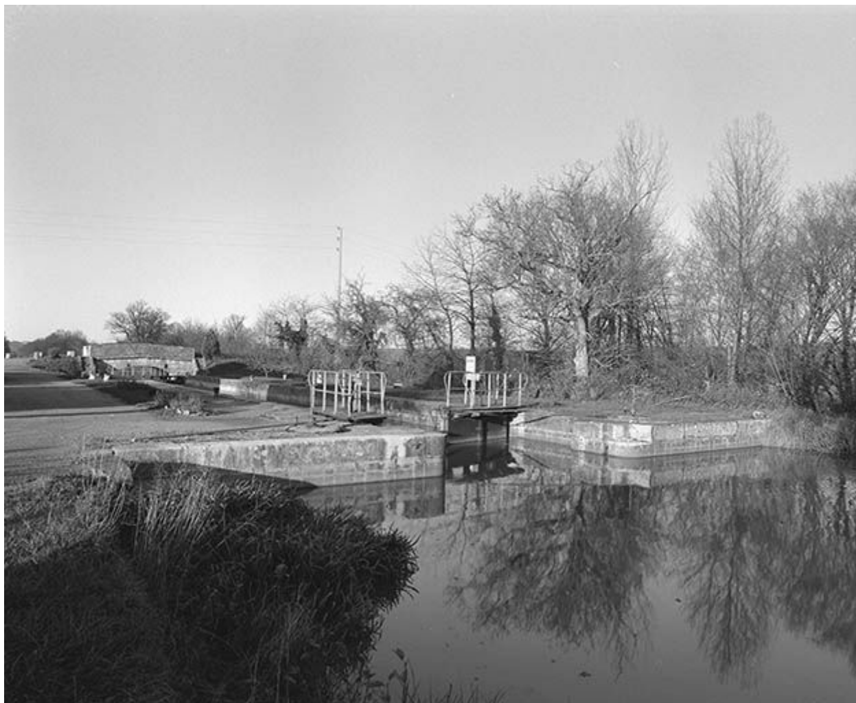
Vue d'ensemble prise de l'amont.
