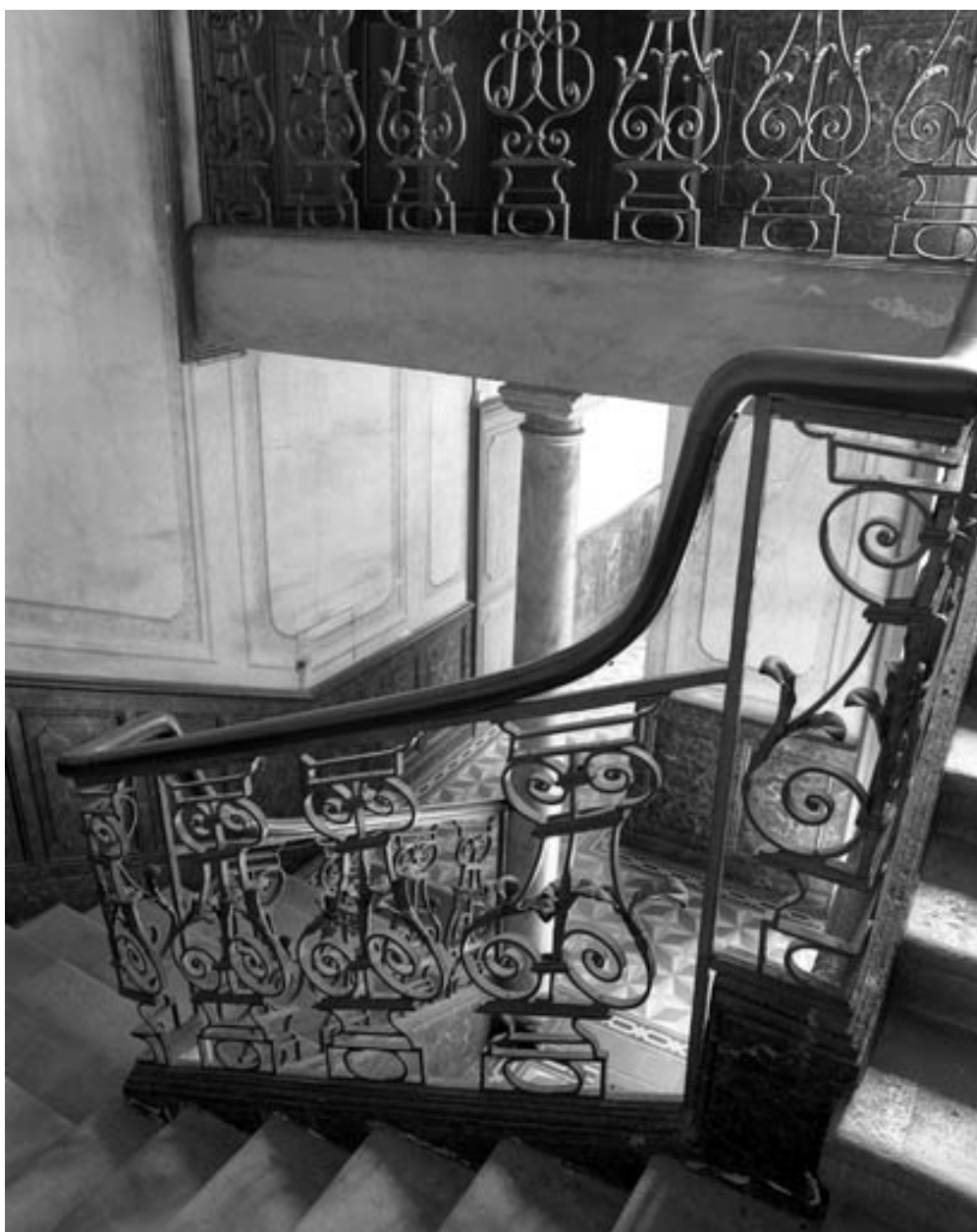
Escalier d'honneur : détail de la rampe d'escalier.
