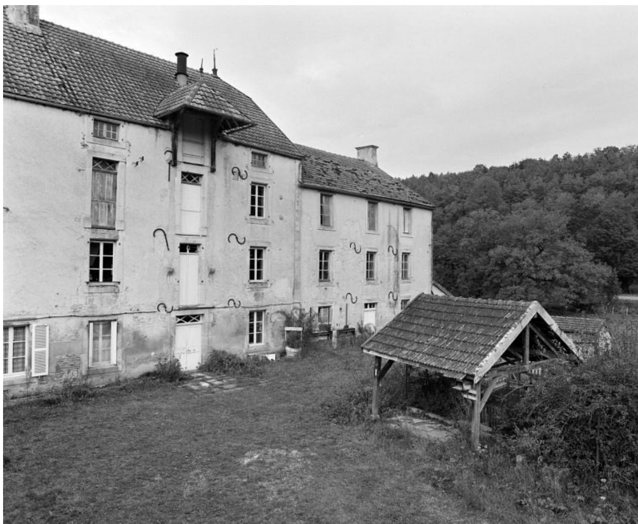
Les bâtiments principaux et le lavoir. Vue prise du sud-est, depuis la cour.
