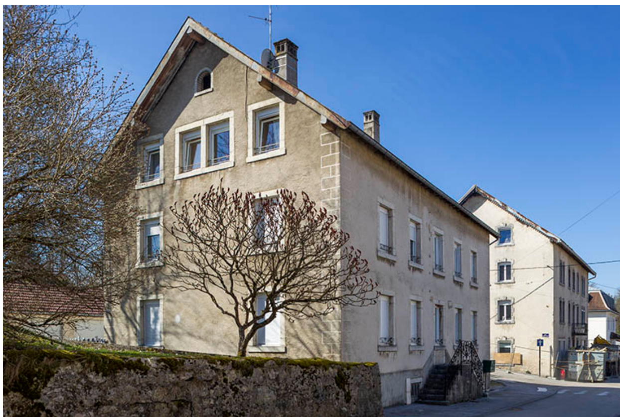
Façades antérieure et latérale gauche.
