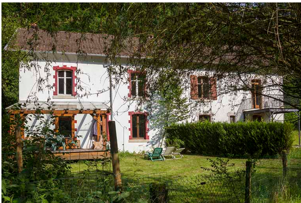
Logements d'ouvriers : façade postérieure.
