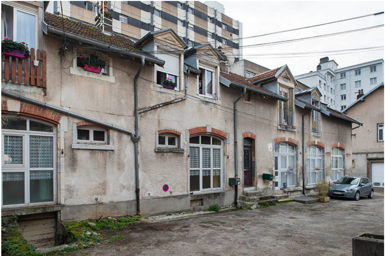
Atelier de fabrication. Façade sur cour.
