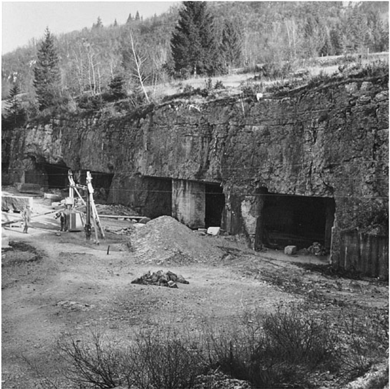
Chantier et entrées de la carrière souterraine.
