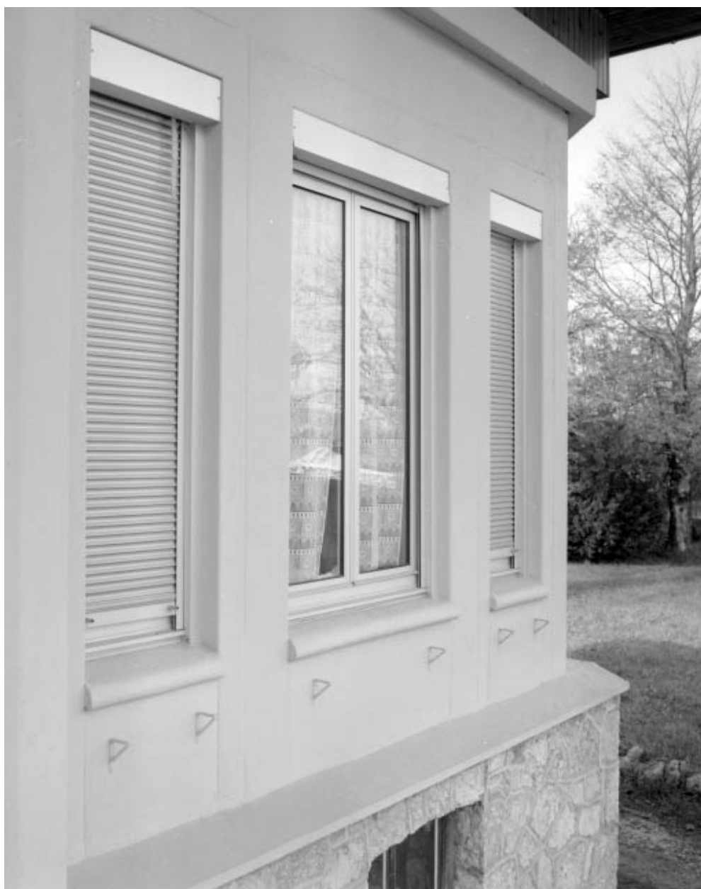
Façade antérieure : fenêtres du renforcement à droite.
