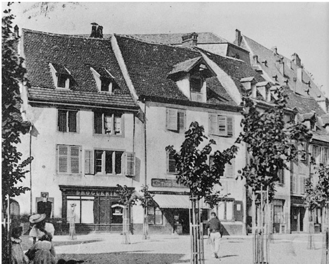
Montbéliard. Le nouveau marché. Place Diemer-Duperret, avant 1908.
